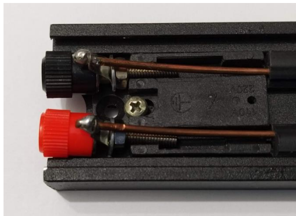
Figura 2: Detalhe das soldas nas chapinhas de metal dos bornes.
