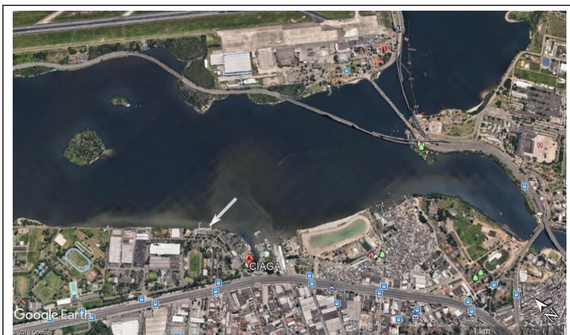
Figura I-9 – Fotografia com a localização do marégrafo ultrassônico (Google Earth). A seta mostra o píer de atracamento do Centro de Instrução Almirante Graça Aranha onde se encontra o marégrafo. Na foto, vemos a Av. Brasil na parte de baixo e uma vista parcial de uma das pistas do Aeroporto Tom Jobim na parte de cima.
