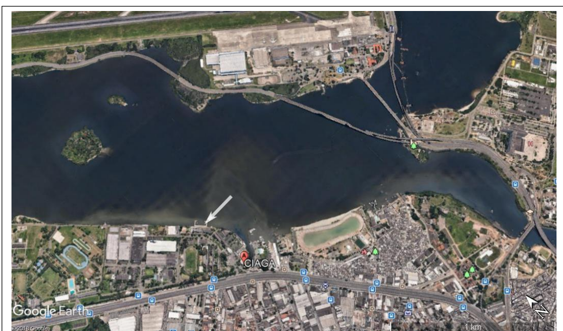
Figura I-8 – Fotografia com a localização do marégrafo ultrassônico (Google Earth). A seta mostra o píer de atracamento do Centro de Instrução Almirante Graça Aranha onde se encontra o marégrafo. Na foto, vemos a Av. Brasil na parte de baixo e uma vista parcial de uma das pistas do Aeroporto Tom Jobim na parte de cima.
