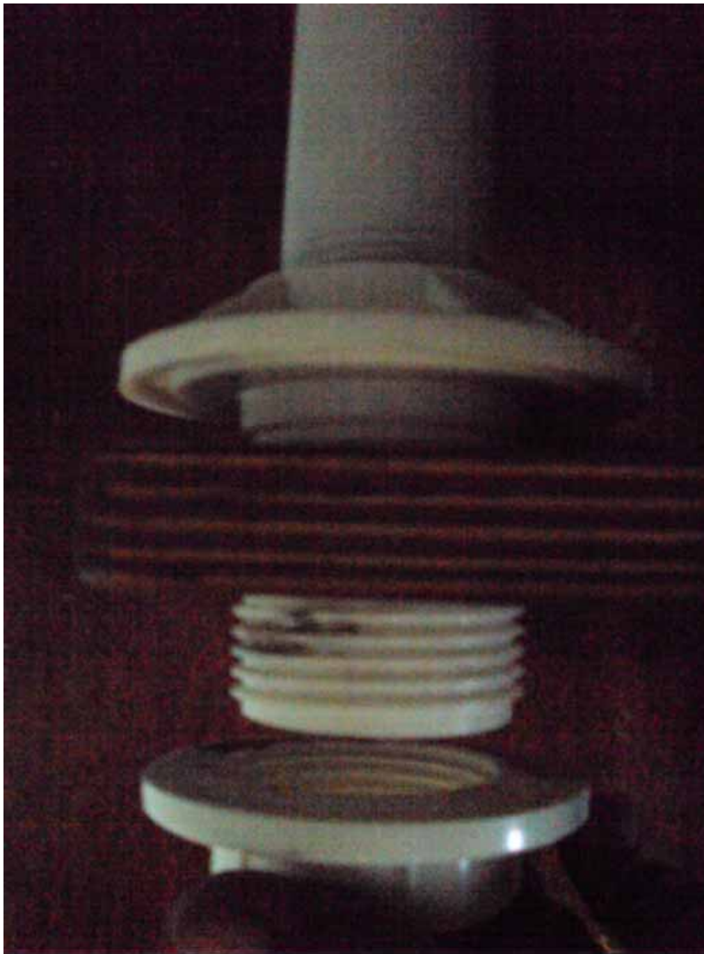
Figura A.46 – Colocando a peça para enroscar o flange e conseqüentemente fixar a coluna de PVC.
