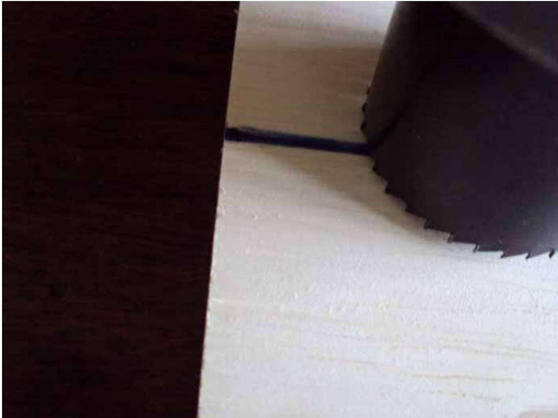
Figura A.22 – Detalhe da serra copo fazendo furo na base.
